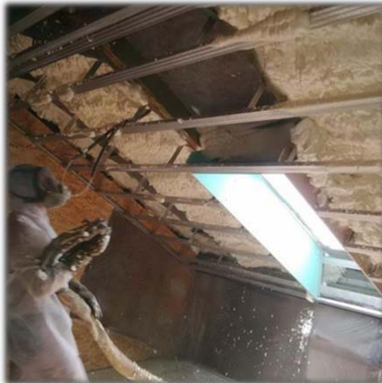
Figure 7 : Isolation des rampants avec l'ossature secondaire installée avant la projection
