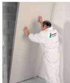
Disposez deux cales de 1 cm au sol. Appliquez le panneau contre le mur. Le panneau doit être en butée au plafond.
