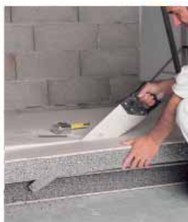
Reportez la hauteur sol-plafond moins 1 cm et sciez côté plaque de plâtre.
