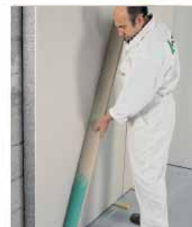
Alignez les panneaux en les frappant avec une grande règle de bois.
