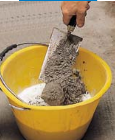
Préparation de la barbotine d'accrochage composée de Mapecem et Planicrete
