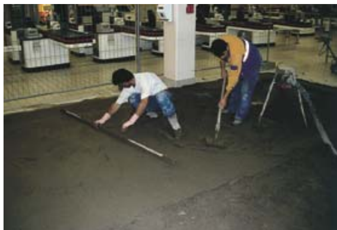
Réparation rapide d'une chape dans un supermarché
