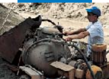
Malaxage et pompage de Mapecem avec une installation automatique
