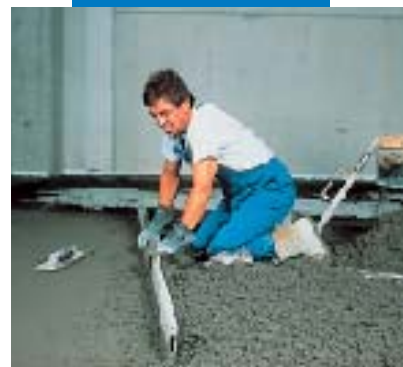
Etalement et damage du mélange Mapecem
