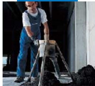
Alimentation du mélange Mapecem
