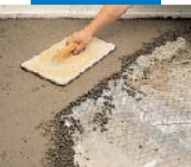
Recouvrement des tuyaux ou canalisations avec un treillis métallique de renfort
