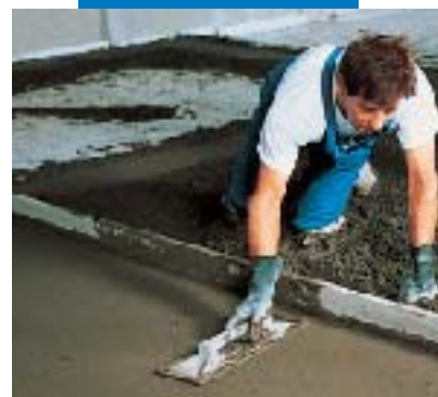
Finition par talochage du mélange Mapecem
