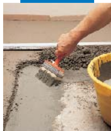
Application de la barbotine d'accrochage pour chape adhérente Mapecem
